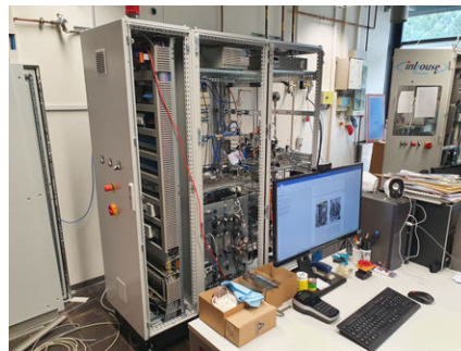
Abbildung 3.24: Teststand für die Untersuchung des URFC-Stacks
